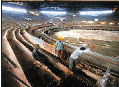
۳ و ۲ - مجتمع ورزشی تهیاگ راج (Thiyagraj) در دست احداث
